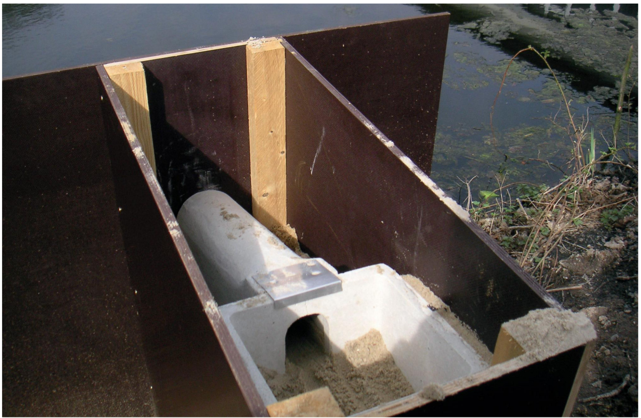
Einbau der Brutröhre in den Kasten
