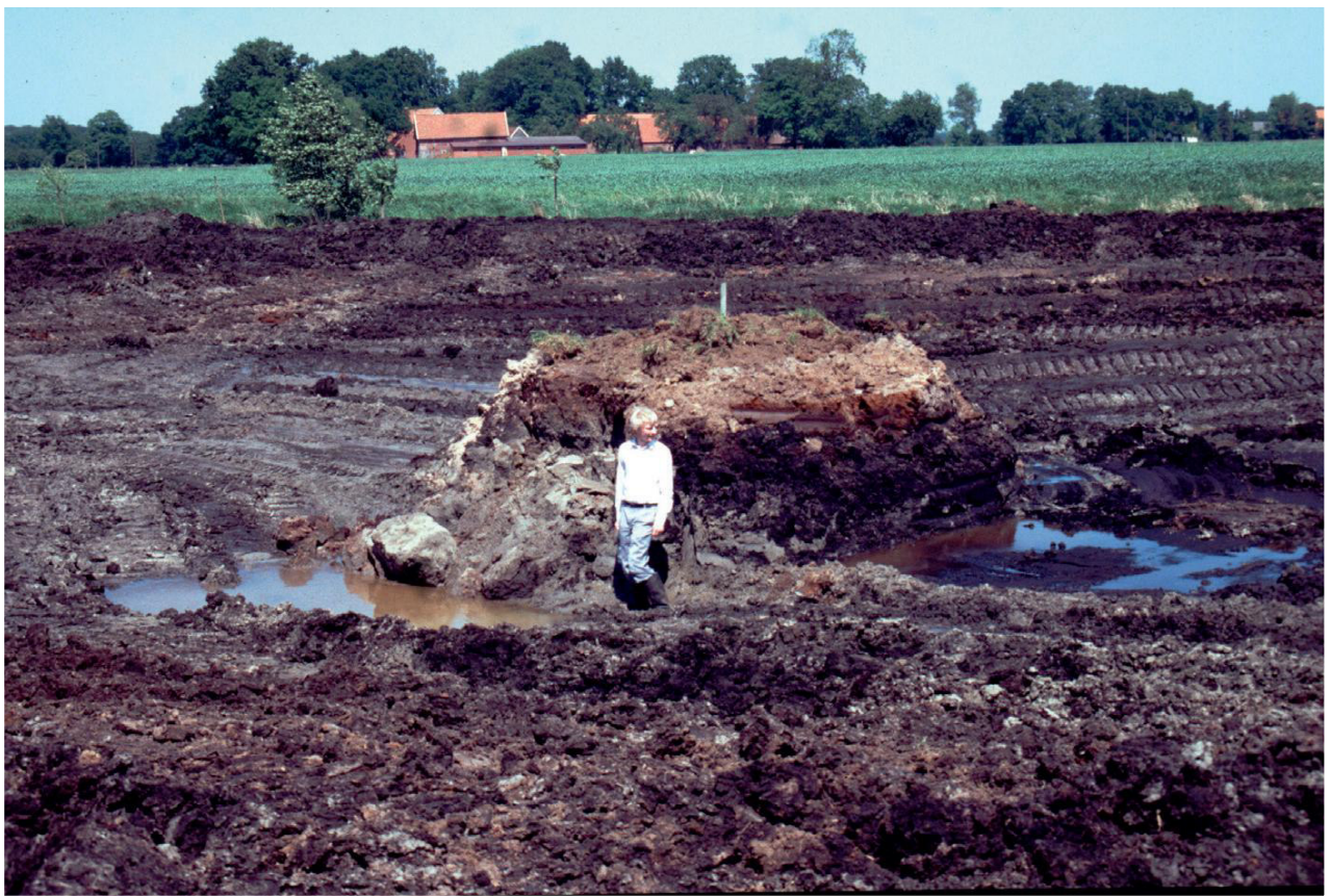
23. Mai 1989 – Rolf Wellinghorst begutachtet die Baustelle
